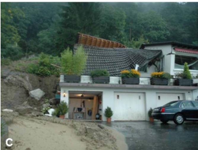
Fig. 1: Schadenereignisse durch Sturz- und Rutschprozesse. A) Felsabbruch von rund 100 m 3 auf Rigi Staffelhöhe am 10. Dezember 2001. Starke Beschädigung eines Wohnhauses infolge Grossblockschlags. B) Unbewohntes Wohnhaus innerhalb der Permanenttrutschung „Kaltbad“. Gebäudedeformation und Rissbildung durch differentielle Bewegungen. C) Durch einen Spontanrutsch zerstörtes Wohnhaus im Siedlungsgebiet „Laugneri“ (Augustunwetter 2005). D) Wohnhausrohbau im Siedlungsgebiet „Linden“. Sekundärblockschlag vom 25. April 2008.
