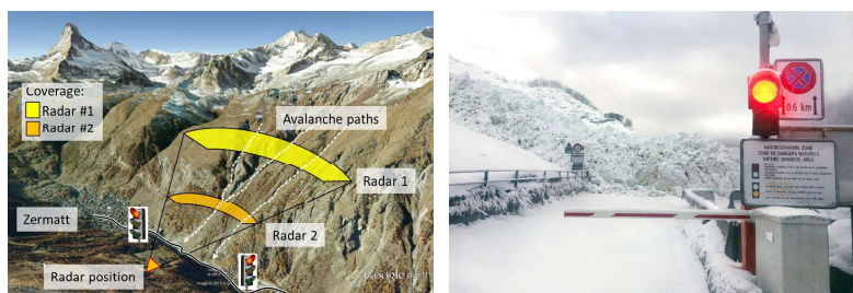
Abbildung 4: Die Radarsysteme befinden sich auf der den Lawinenzügen gegenüberliegenden Talseite (links). Schranke und Ampel werden automatisch bei der Detektion Lawinen aktiviert (rechts).
