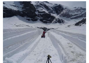
Erstellung eines ca. 100 m langen Kanals mit Hand-Schneefräsen.
