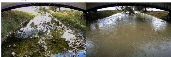
Abbildung 3: Rheintaler Binnenkanal bei Normalstand (links) und bei Hochwasser (rechts).
