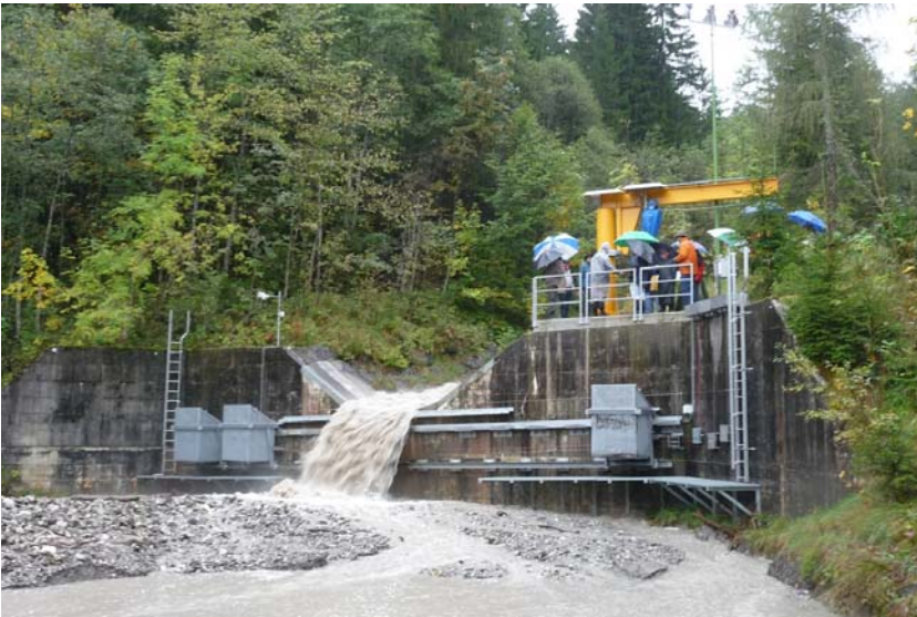
Abbildung 2: Der Geschiebesammler Erlenbach am Tag der offenen Tür im Alptal. Die drei beweglichen Fangkörbe können auf einer Tragschiene in den Abflussstrahl hinein gefahren werden und dienen zur Messung von Geschiebetransportraten.
