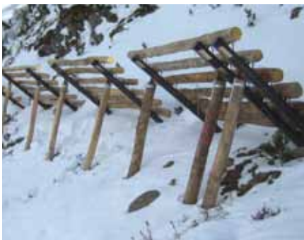
Abb. 4: Lawinerverbauung Crap Milan, Bivio 2011. Typ LM Dk 2.5, Randwerk mit Doppelstütze.
