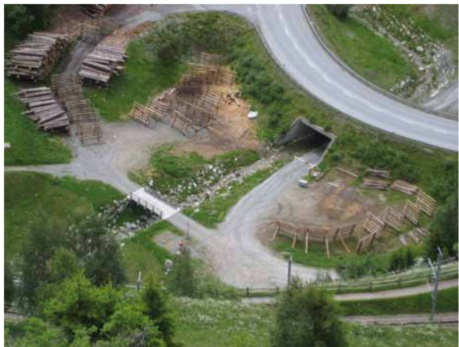
Abb. 2: Lawinenverbauung Plauncas Nireil, Tujetsch 2011. Für die Montage bereitgestellte Werke auf dem Vormontageplatz.
