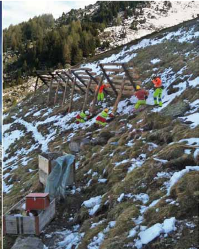
Abb. 3b: Lawinerverbauung Crap Milan, Bivio 2011. Montage der Werke;
