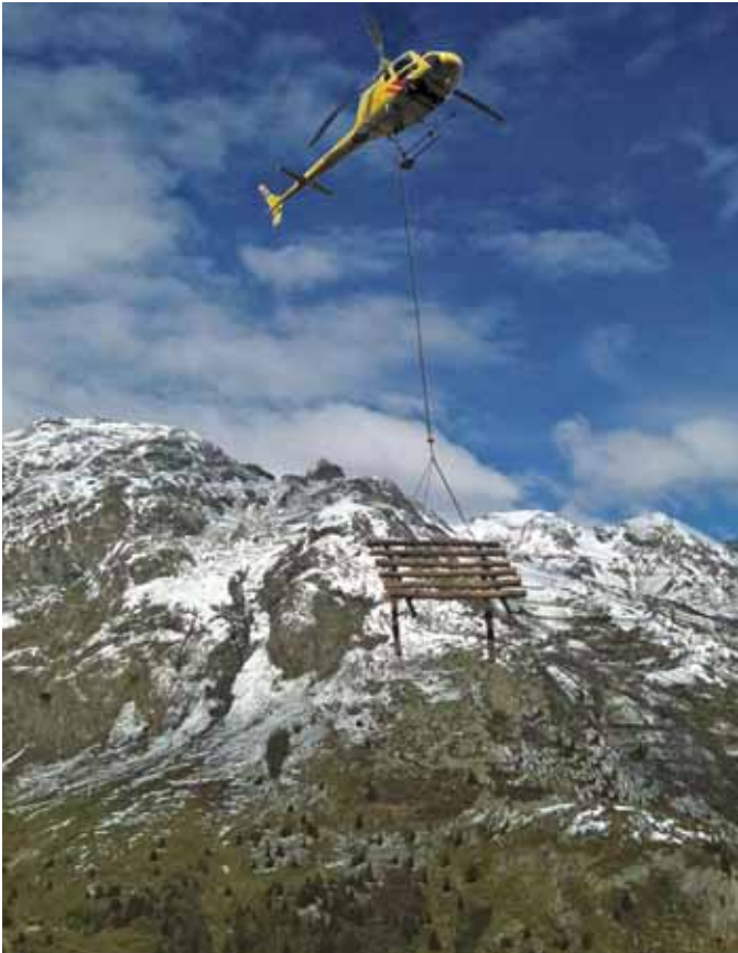
Abb. 3a: Lawinerverbauung Crap Milan, Bivio 2011. Einfliegen der Werke mit dem Heli;
