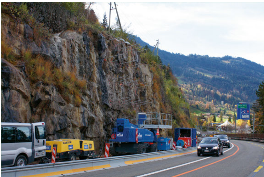
Abbildung 6: Bau des Schutznetzes. Foto: ASTRA, Herbst 2013
