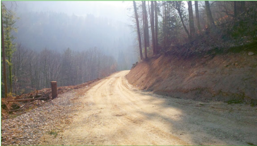
Figure 5: Réalisation de la desserte de Vellerat
