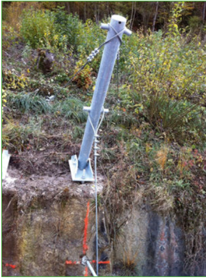
Abbildung 4: Detailansicht einer Pendelstütze. Foto: Alpinice Bauconsulting, Herbst 2013
