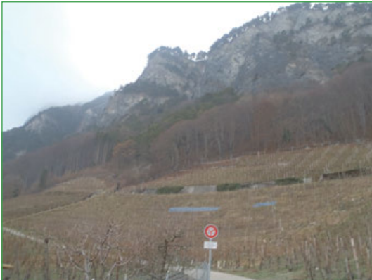
Abbildung 3: Teusawald-Flue mit Auslaufbereich am Dorfrand (Foto: tur gmbh).
