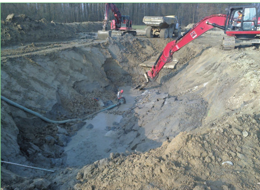
Abbildung 6: Die Leitwerke werden tief im Boden fundiert und nachher zugeschüttet.
