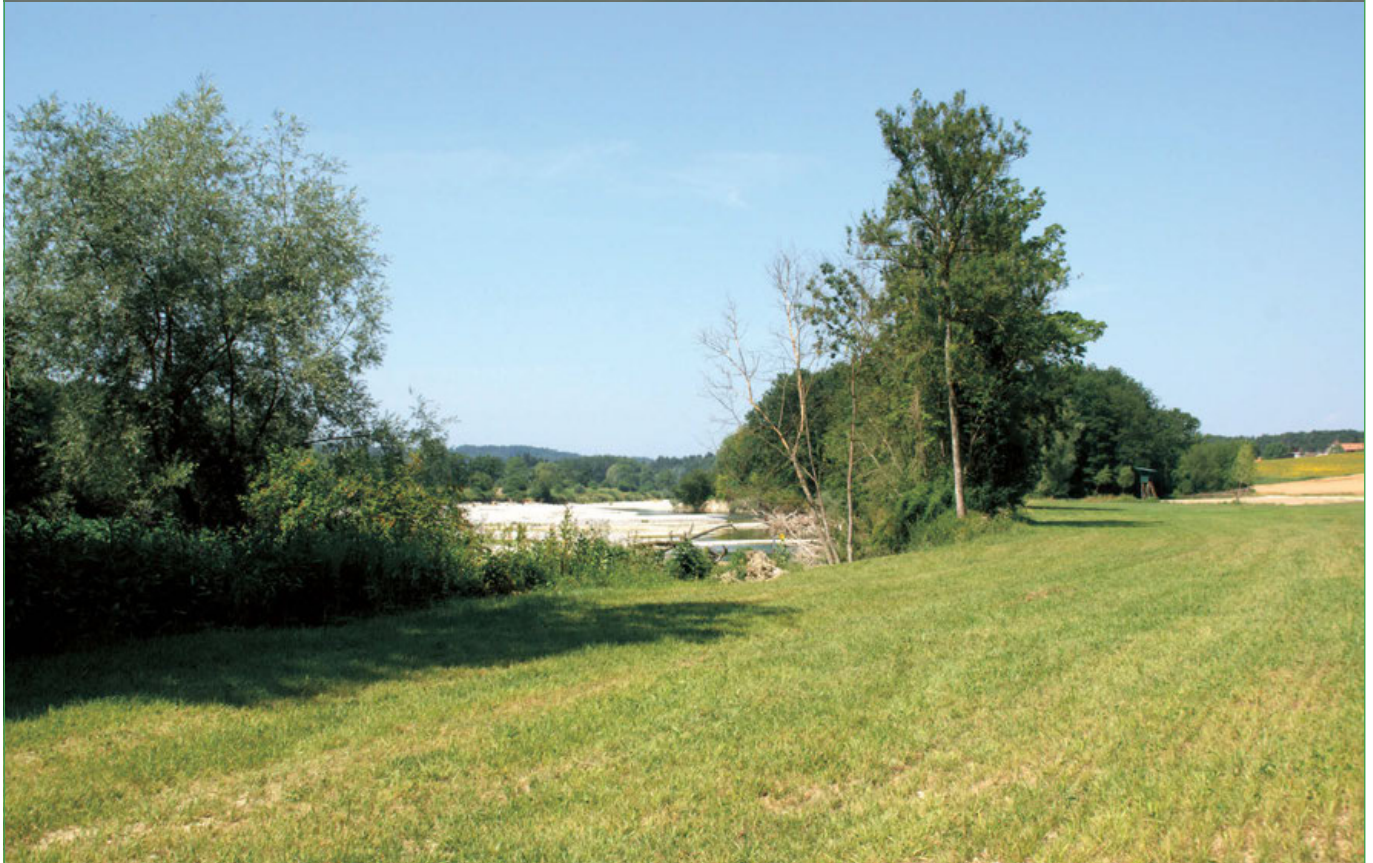
Abbildung 7: Bilder nach Bauabschluss, Sommer 2015.
