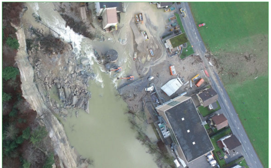
Abbildung 1: Drohnenaufnahme des Schadengebietes mit den Ablagerungen zwischen Kantonsstrasse und Bahnlinie. Foto: ZSO EMME am 11.1.2016
