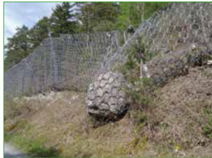
Abbildung 6: Links: Blockschlagereignis im November 2012 in Gurtellen. Dank dem Einsatz der NGA-Anlage konnte eine Zugkollision verhindert werden. Mitte: Ein ca. 3 m 3 – Block wurde von den Schutznetzen oberhalb des Gotthardbasistunnels in Erstfeld aufgehalten. Dieses Ereignis hat Mängel an der Funktionsweise der NGA-Anlage aufgezeigt. Rechts: Felssturzereignis in Gurtellen 2015, welches einen Direkttreffer des vorbeifahrenden Zuges verursachte. Dieses Restrisiko kann auch mit der NGA-Anlage nicht abgedeckt werden.
