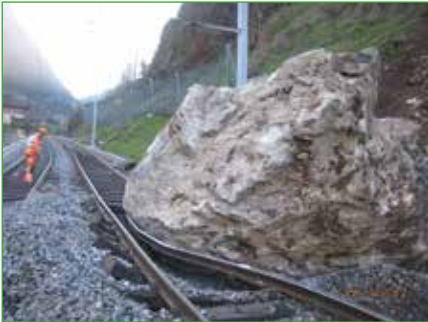
Abbildung 6: Links: Blockschlagereignis im November 2012 in Gurtellen. Dank dem Einsatz der NGA-Anlage konnte eine Zugkollision verhindert werden. Mitte: Ein ca. 3 m 3 – Block wurde von den Schutznetzen oberhalb des Gotthardbasistunnels in Erstfeld aufgehalten. Dieses Ereignis hat Mängel an der Funktionsweise der NGA-Anlage aufgezeigt. Rechts: Felssturzereignis in Gurtellen 2015, welches einen Direkttreffer des vorbeifahrenden Zuges verursachte. Dieses Restrisiko kann auch mit der NGA-Anlage nicht abgedeckt werden.
