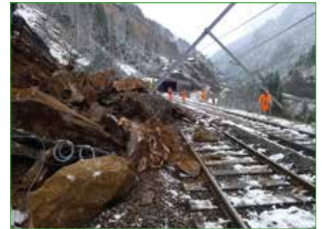
Abbildung 6: Links: Blockschlagereignis im November 2012 in Gurtellen. Dank dem Einsatz der NGA-Anlage konnte eine Zugkollision verhindert werden. Mitte: Ein ca. 3 m 3 – Block wurde von den Schutznetzen oberhalb des Gotthardbasistunnels in Erstfeld aufgehalten. Dieses Ereignis hat Mängel an der Funktionsweise der NGA-Anlage aufgezeigt. Rechts: Felssturzereignis in Gurtellen 2015, welches einen Direkttreffer des vorbeifahrenden Zuges verursachte. Dieses Restrisiko kann auch mit der NGA-Anlage nicht abgedeckt werden.
