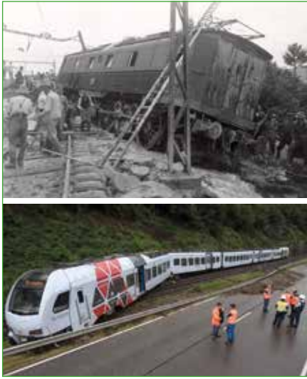
Abbildung 2: Zugsentgleisungen durch Anprall – gestern und heute. Oben: Zugsentgleisung bei der SBB durch Anprall mit Murgangablagerungen an der Rigi Nordlehne im Jahr 1934. Unten: Zugsentgleisung bei einem Regionalzug der Deutschen Bahn nach dem Anprall mit einer Rutschmasse in Rheinland-Pfalz im Juni 2016 (Spiegel Online, 2016).
