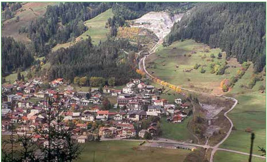
Abbildung 2: Das Dorf Pettneu heute: Zum Schutz vor Muren wurden ein Murauffangbecken und ein Murgerinne errichtet (technischer Schutz) und der schützende Waldgürtel oberhalb des Dorfes vergrößert (forstliche Massnahmen). Das Dorf hat sich weiterentwickelt, aber nur innerhalb der früheren, naturgegebenen Grenzen (Raumordnung).
