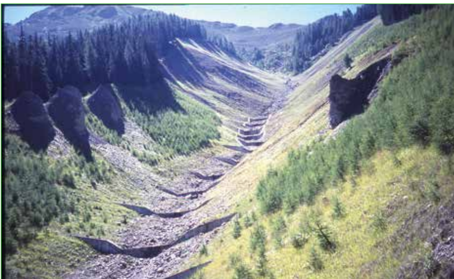
Abbildung 6: Abstaffelung einer Erosionsrunse durch Konsolidierungssperren mit Abböschung, Begrünung und Aufforstung der Bacheinhänge
