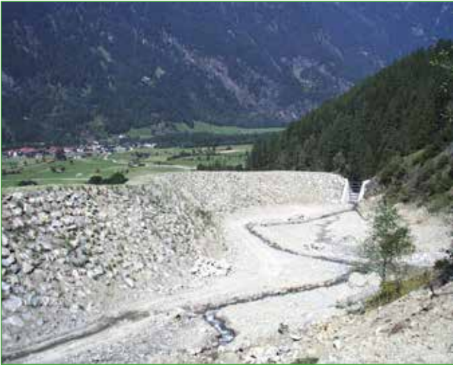
Abbildung 8: Murauffangbecken mit Balkensperre als Auslaufbauwerk
