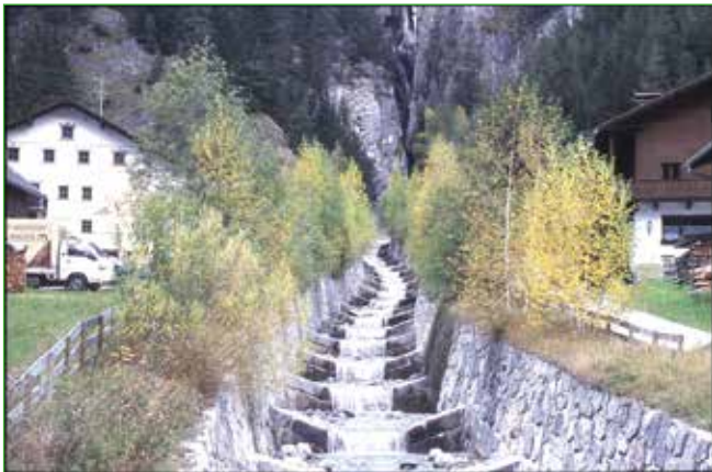
Abbildung 9: Schwemmkegelregulierung durch Grundswellen und beiduf- rige Leitwerke
