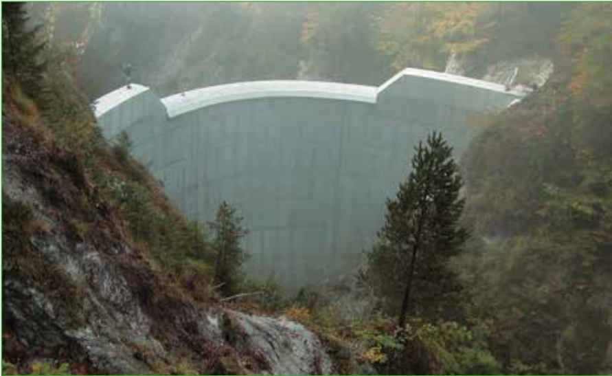
Abbildung 5: Bogensperre zur Hochwasserretention
