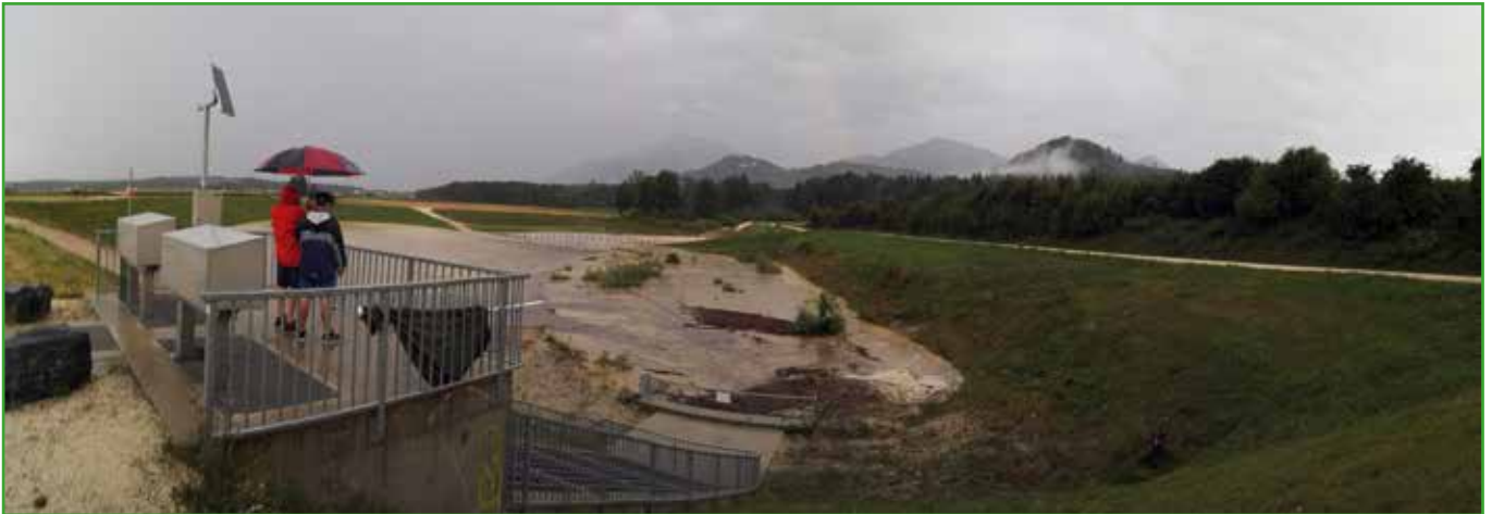
Abbildung 1: Hochwasserrückhaltebecken Gösselsdorf am Suchabach in Kärnten. Ca. 60-jährliches Hochwasser im August 2016.
