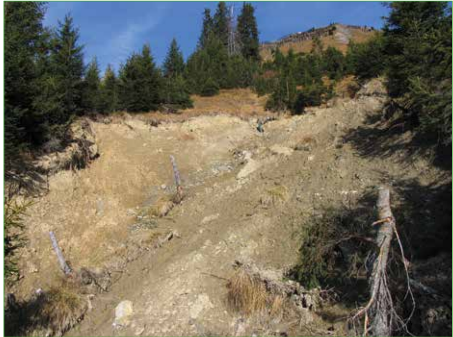
Abbildung 1: Beispiel einer flachgründigen Rutschung in einer Waldlücke (Unwetter vom 22. August 2005 in St. Antönien).
