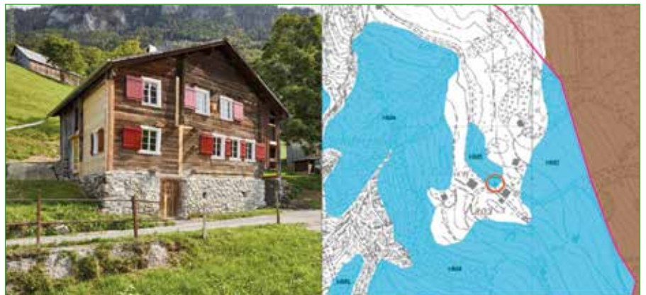
Abbildung 1: Ausschnitt aus der Prozess-Gefahrenkarte Spontanrutschung / Hangmure und Bild des Hauses Tannen. Rot markiert ist die Lage des Hauses am südöstlichen Rand des blauen Gefahrenbereiches (Louis Ingenieurgeologie GmbH und Ingenieure Bart AG, 2012). Bildquelle: www.gataric-fotografie.ch .
