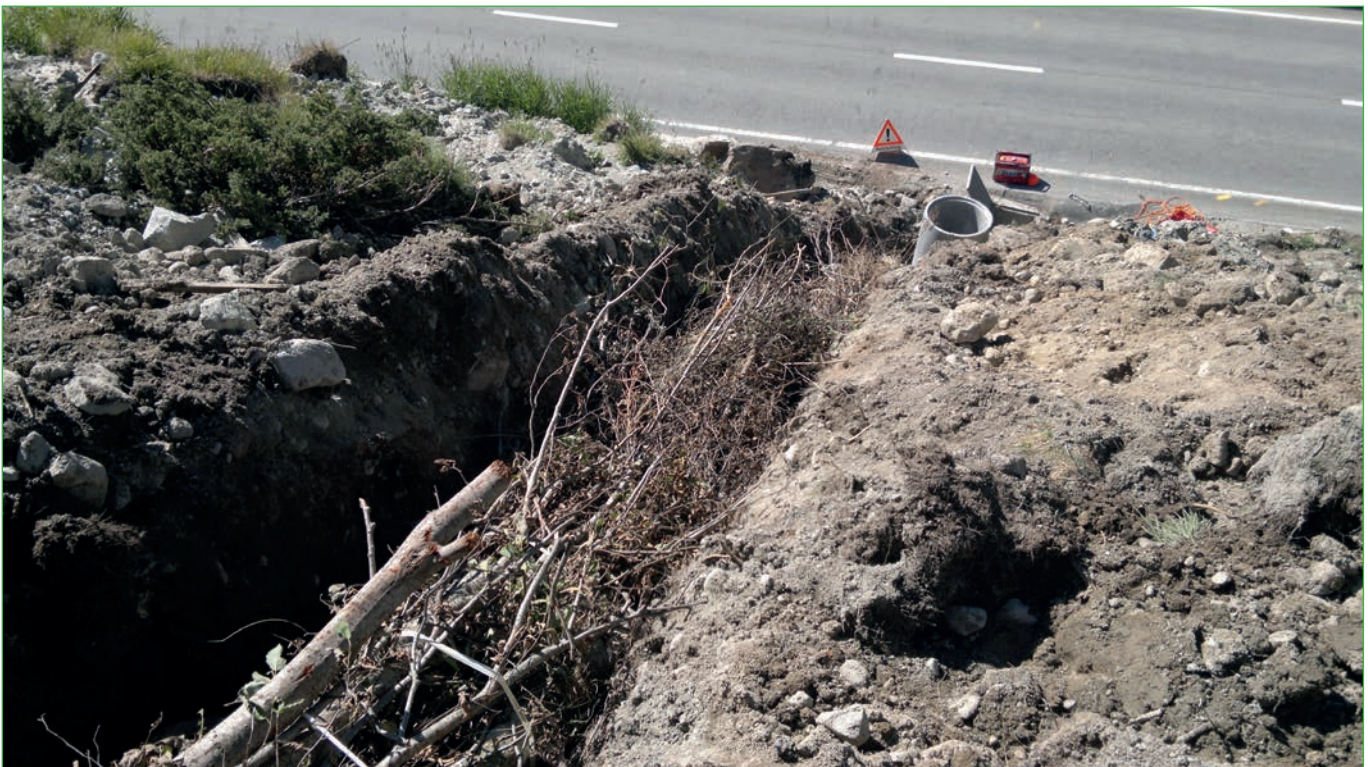
Abbildung 3: Drainage von Hangwasser mit Totfaschinen bleibt lange Zeit funktionstüchtig und benötigt kaum Unterhalt (Foto: Caprez Ingenieure AG).
