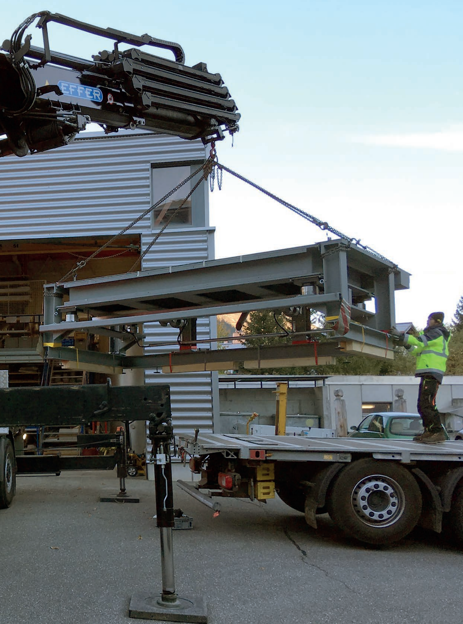
Transport der erneuerten Murgangwaage. Foto: WSL/SLF.
