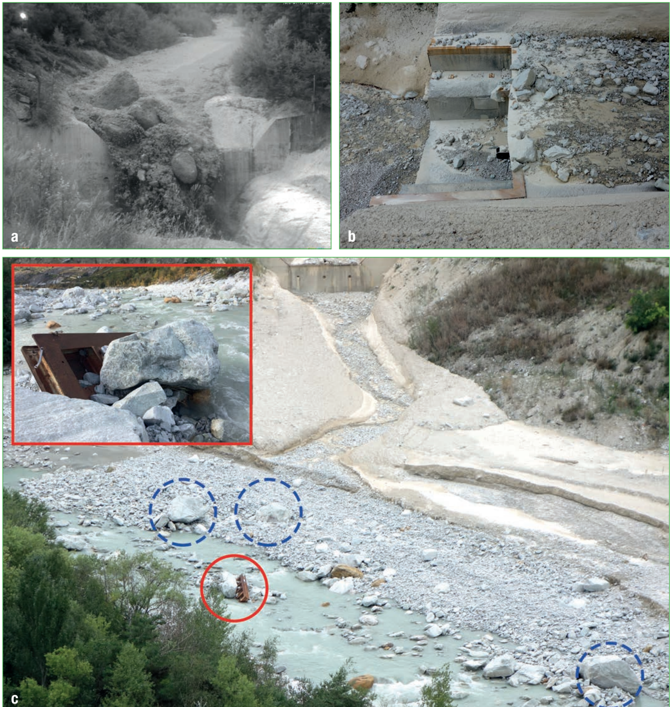
Abbildung 1: Murgangereignis im Illgraben (VS) vom 22. Juli 2016 und Bilder der zerstörten WSL-Murgangwaage. a) Ansammlung sehr grosser Blöcke im Frontbereich des Murgangs im Gerinne oberhalb der Murgangwaage, b) leere Aussparung für die Murgangwaage nach dem Verlust der Waageplattform, c) Position der weggerissenen Waageplattform im Flussbett der Rhone (roter Kreis, rot umrahmtes kleines Bild) und der grossen Blöcke (blau gestrichelte Kreise) im Mündungsbereich des Illgraben, wenige hundert Meter unterhalb des ursprünglichen Messstandorts.
