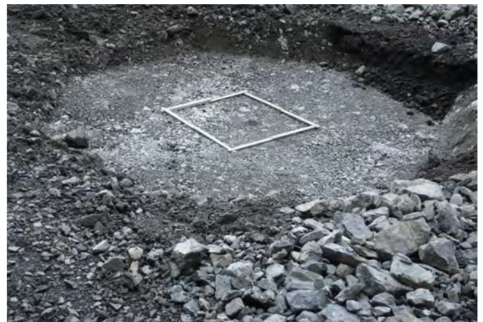
Abbildung 2: Verdichteter Boden infolge Einschlag eines 8000 kg schweren Quaders.
