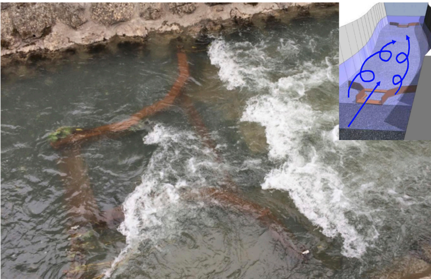
Abbildung 5: Stahltrichterbuhne zur Remobilisierung von Feinsedimenten (D. Hodel).
