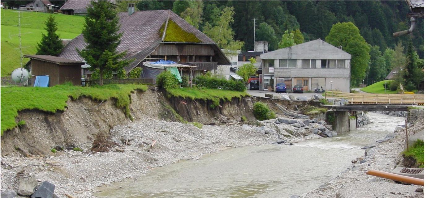
Figure 1: Erosion des berges de la Trueb pendant les crues de 2005. Photo: Flussbau AG SAH.
