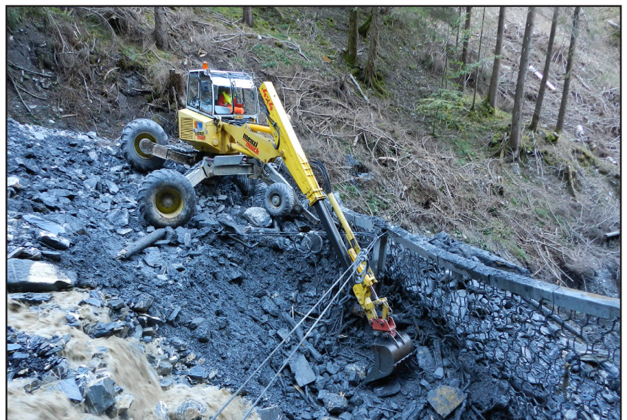
Abbildung 4: Leerung eines Murgangschutznetzes von der Bergseite her mit Schreitbagger (Quelle: Geobrugg AG).
