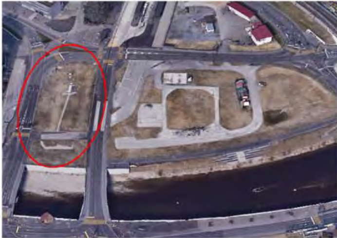
Drohnaufnahme des Seetalplatz (in Rot), Emmen
